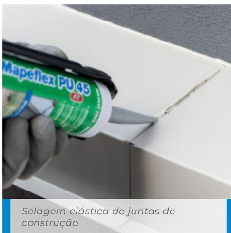
Selagem elástica de juntas de construção
